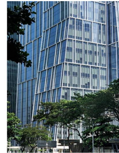
Gambar 2.13 Strategi sirip peneduh pada Sequis Tower Sumber: KPF Associates, 2019
