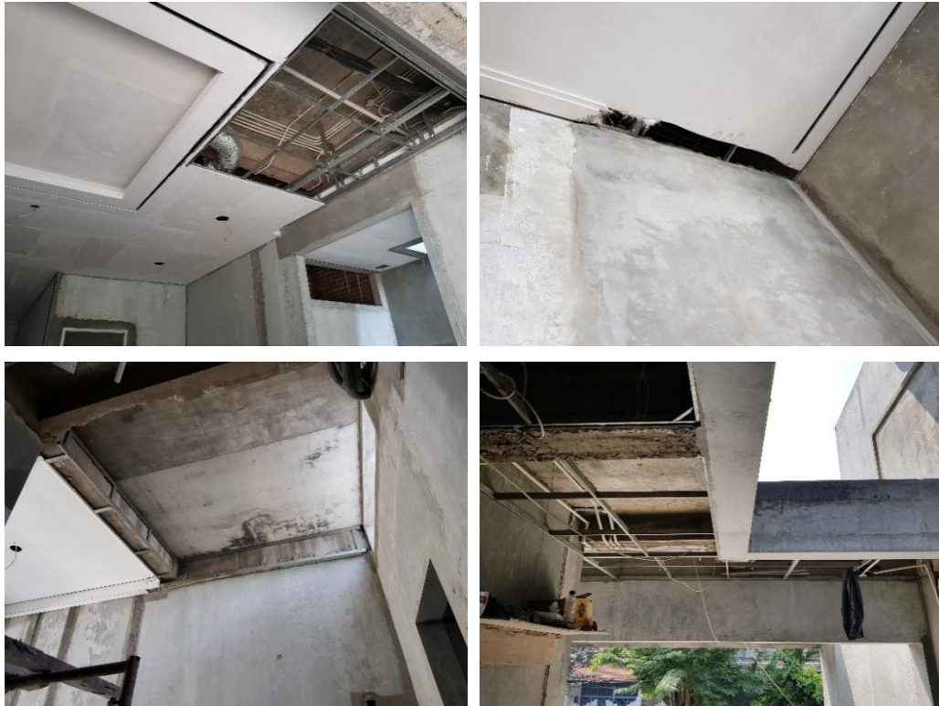
Gambar 4.6. Pemasangan Plafond Gypsumsheet , t = 9 mm Lantai Satu
