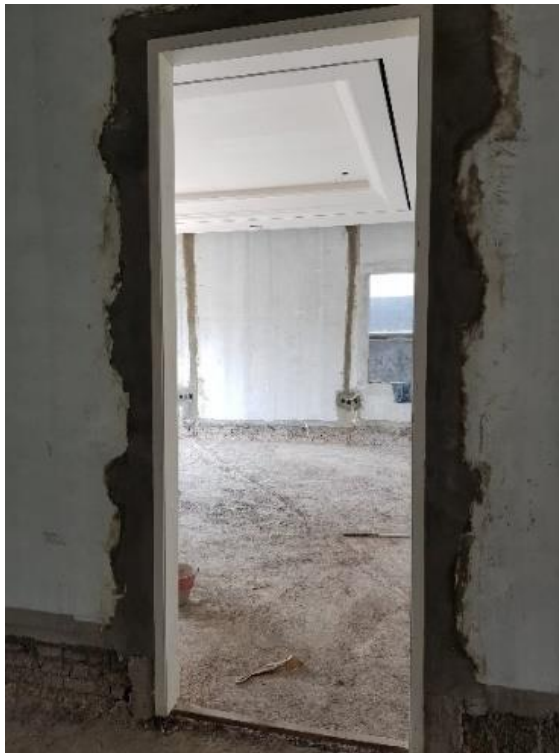
Gambar 4.5. Pembuatan dan Pemasangan Kusen Kayu Merbau (Kelas I)
