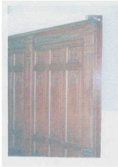
Foto 3.23. Pelapis dinding dari panel kayu Jati yang dilengkapi dengan list dan ukiran
