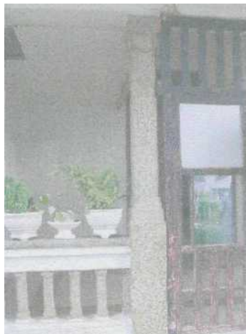
Foto 3.1. Kolom yang terbuat dari terazzo
