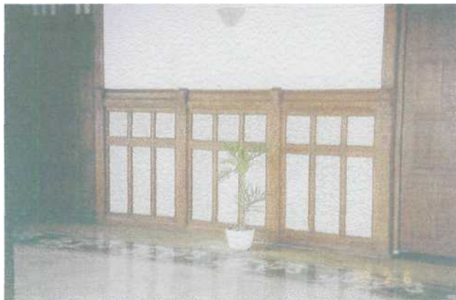
Foto 3.24. Pelapis dinding dari panel kayu Jati kualitas tinggi dikombinasi dengan asbestos cement , diberi list yang diukir
