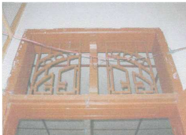
Foto 3.3. Teralis ventilasi di atas pintu yang terbuat dari besi tempa
