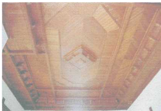
Foto 3.20. Plafond ruang gallery yang terbuat dari kayu jati
