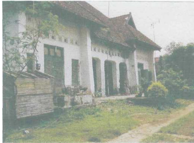
Foto 3.10. Rumah Jl. Kesawean
