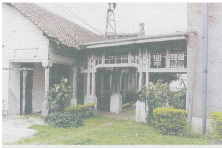
Foto 3.30. Koridor yang menghubungkan bangunan utama dengan bangunan service
