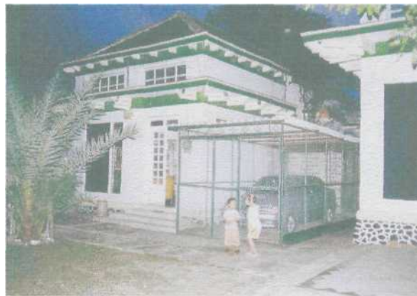
Foto 3.7. Bangunan paviliun rumah Jalan Pandowo
