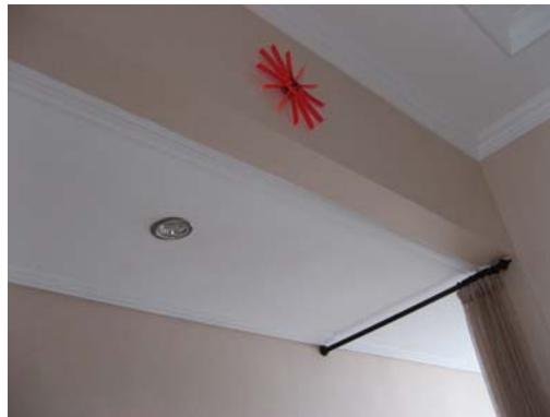
Gambar 4.16. Plafon Kamar Tidur Utama
