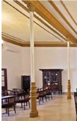
Gambar Kolom pada Area Ballroom Hotel Daroessalam
