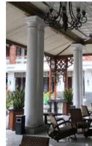
Gambar Kolom Tuscan pada Teras depan Hotel Daroessalam. Gambar Dokumentasi Pribadi
