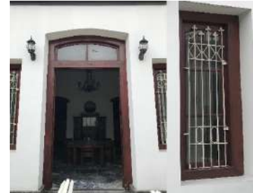
Gambar Pintu dan jendela pada Ruang Belakang Hotel Daroessalam. Gambar Dokumentasi Pribadi
