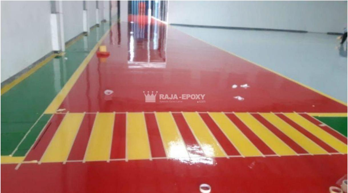
Gambar 4.26 Solusi perancangan yaitu jalur *forklift* untuk *operator*
