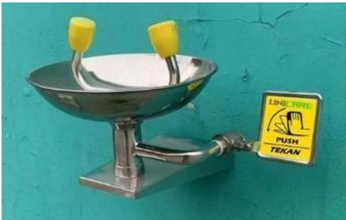
Gambar 4.15 Solusi APD yaitu mesin *wash eyes*
