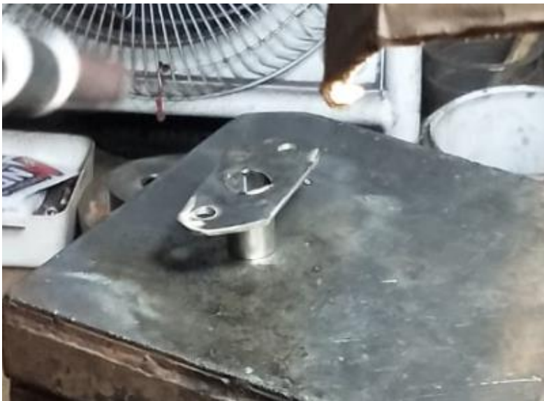
Gambar 3.46 Proses Menghubungkan Flange dengan Pipa Menggunakan Proses Las
