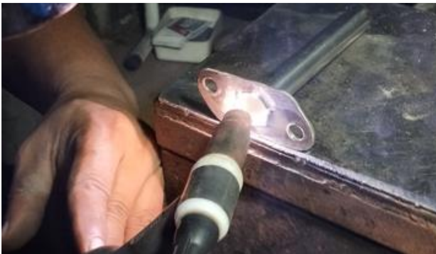
Gambar 3.41 Proses Las pada Flange terhadap pipa jalur drone killer
