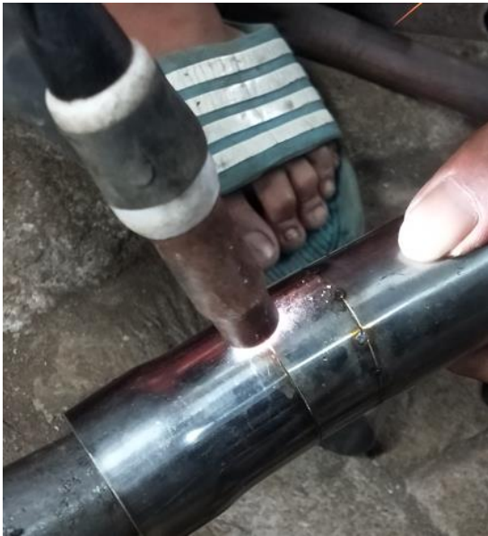
Gambar 3.24 Proses Las Sementara Untuk Memposisikan Pipa pada tempat yang benar
