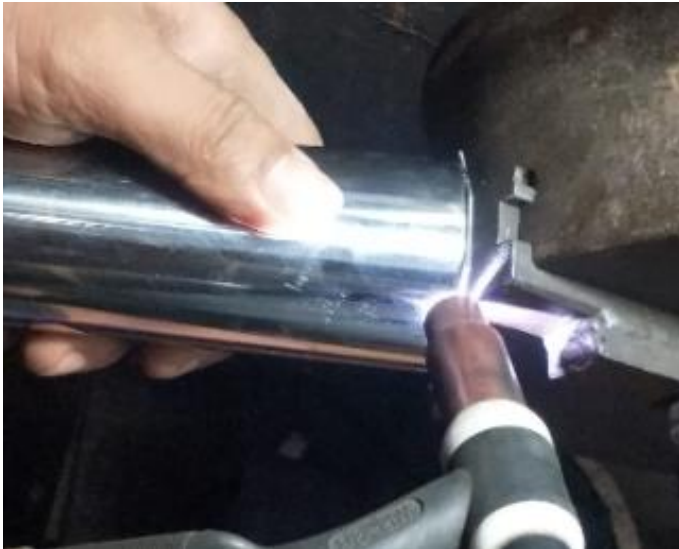
Gambar 3.47 Proses Penyatuan Pipa dengan Plat
