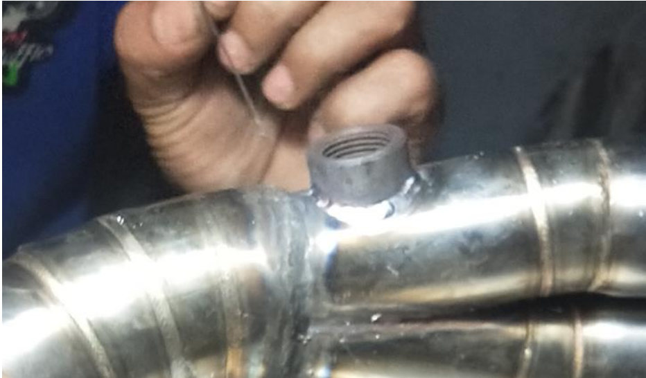
Gambar 3.34 Proses Pemasangan Mur Sensor O 2 dengan Proses Las
