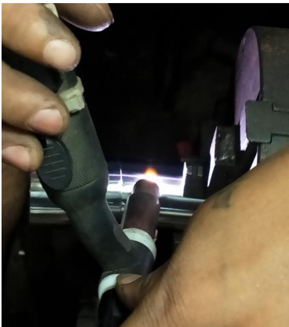
Gambar 3.25 Proses Las Penyatuan Kedua Pipa
