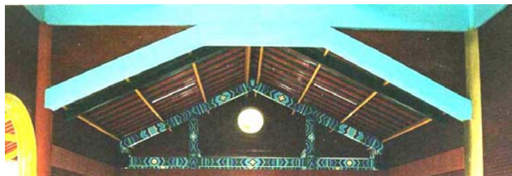
Gambar 3.11 Plafon lantai pertama di Masjid Cheng Hoo
