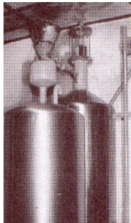
Gambar 2.11.: Instalasi Penampungan Minyak Kayu Putih Sumber: Budi Daya dan Penyulingan Kayu Putih, hlm. 54.
