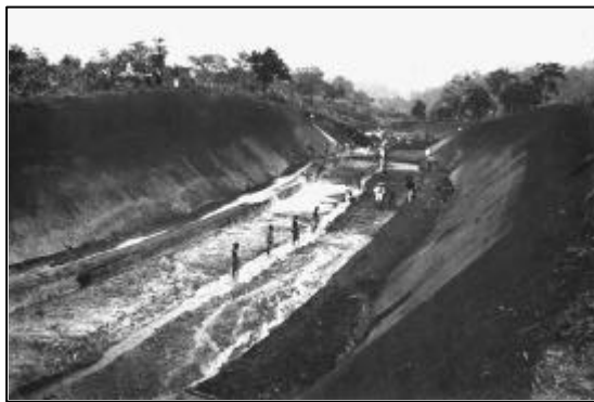
Gambar 1A. Pembuatan konstruksi jalan kereta api antara Cianjur dan Bandung. Keadaan phisik yang berat dan tidak menguntungkan ini memerlukan banyak sekali tenaga kerja
