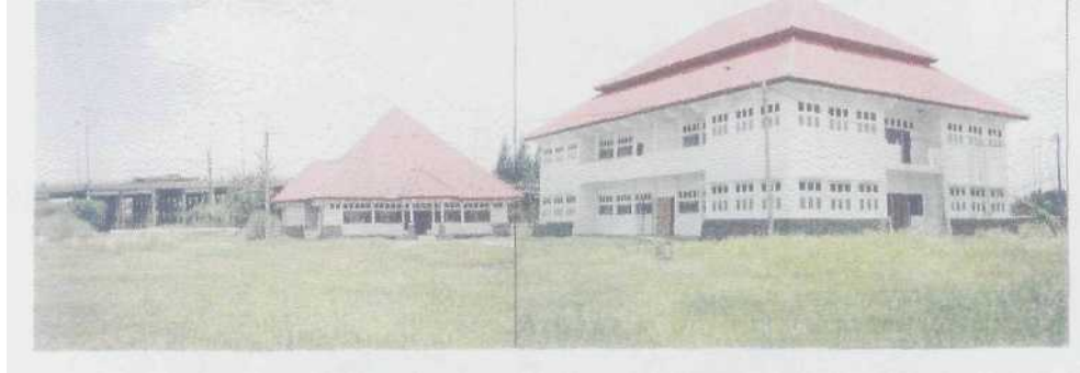
Gambar 2.1.2 Gedung pameran tetap (kanan ) dan gedung tata usaha (kiri)
