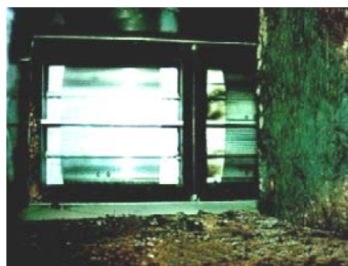
(c) Pada ducting AC
