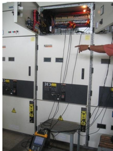
Gambar 3.6 Pemasangan alat ukur pada sisi incoming
