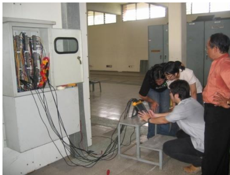
Gambar 3.5 Pemasangan alat ukur pada terminal box
