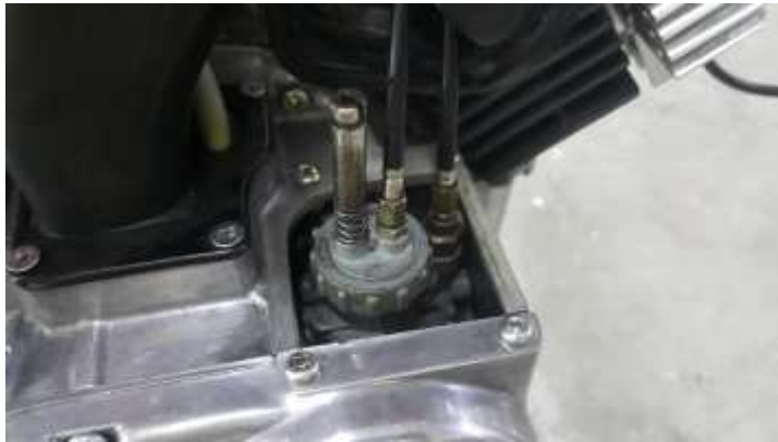
Gambar 4.43 Hasil Pemasangan carburetor cap .
