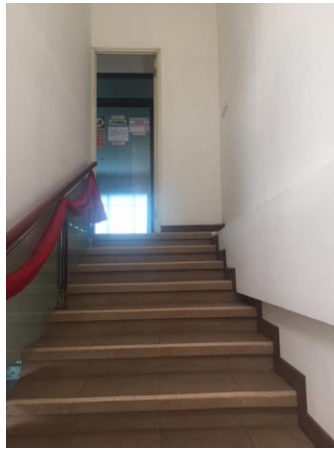
Gambar 3.35. Tangga menuju lantai 3
