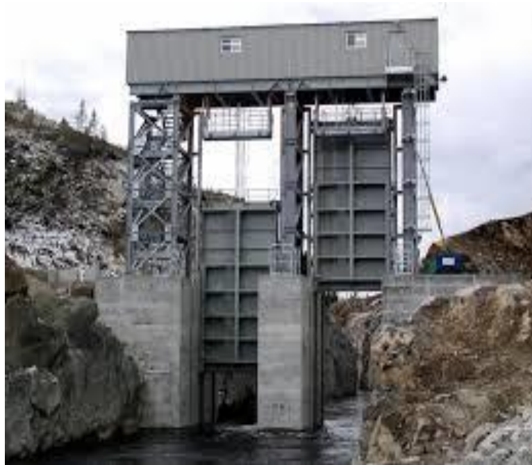
Gambar 2.5. Pintu Masuk Air ( Intake Gate )
