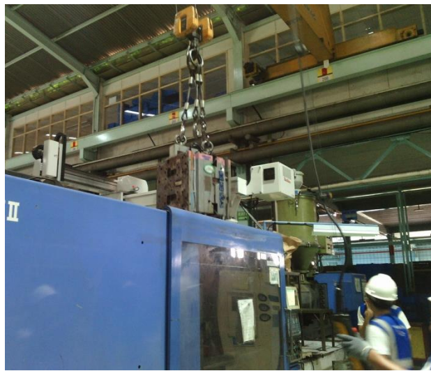
Gambar 4.4 Proses Pemasangan Mold
