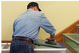
Gambar 2.27. Meletakkan panel kaca pada *grid* dengan menggunakan alat bantu *vacuum cups*.
