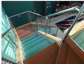
Gambar 2.32. Tangga lantai kaca laminasi dengan konstruksi dua struktur
