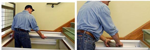
Gambar 2.23. Pemasangan *grid* secara vertikal dan horisontal
