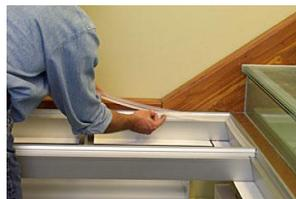
Gambar 2.24. Pemasangan silikon pada tepi bagian dalam sekeliling kerangka.
