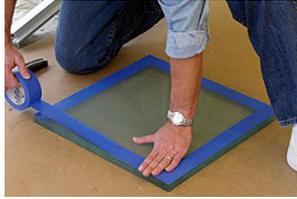
Gambar 2.26. Pemasangan lapisan pada sekeliling panel kaca.
