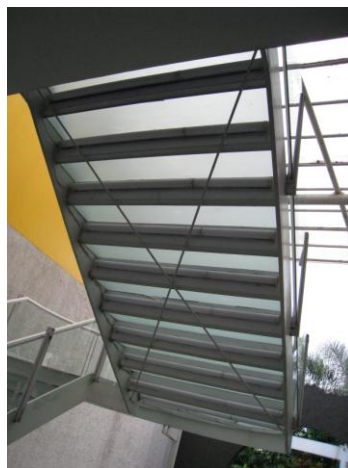
Gambar 3.12. Tangga lantai kaca tampak bawah yang diberi lapisan sandblasted sehingga bayangan orang di atasnya tidak tampak jelas
