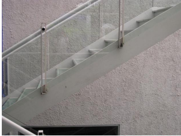
Gambar 3.11. Tangga lantai kaca tampak samping
