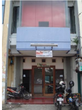
Gambar 2.19 Tampak depan bangunan
