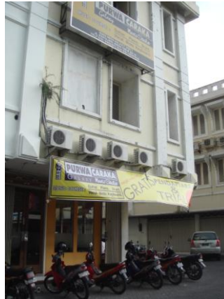
Gambar 2.25 Tampak depan bangunan
