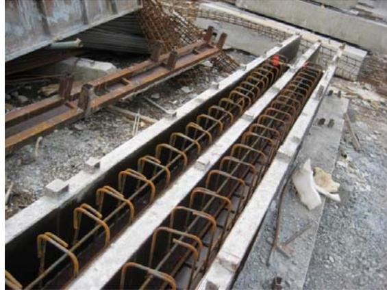
Gambar 3.6. *Setting* Tulangan Balok di Dalam Bekisting
