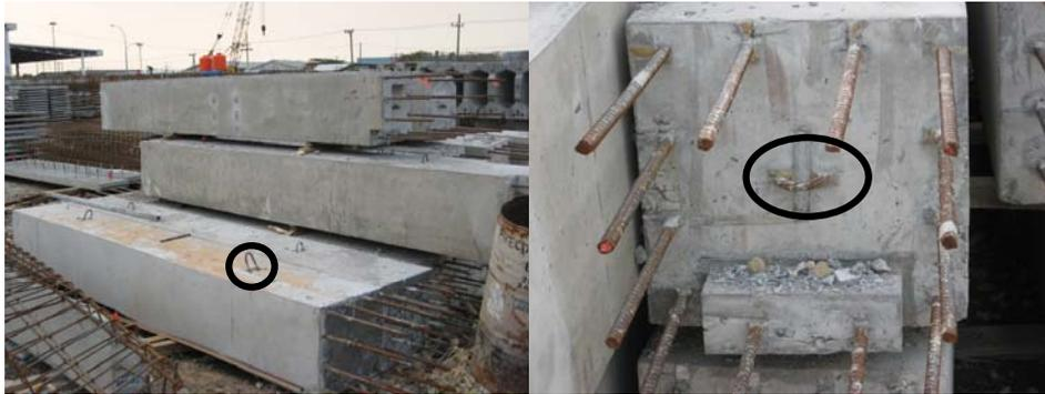
Gambar 3.16. Tulangan Angkat Horizontal (Kiri) dan Tulangan Angkat Vertikal (Kanan) Pada Kolom
