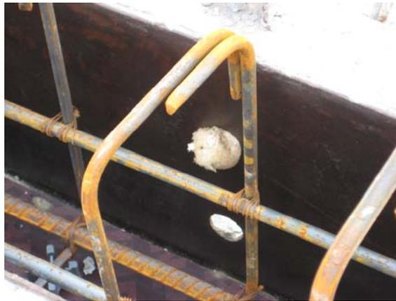
Gambar 3.15. Pemasangan Gabus Pada Sela-sela Bekisting
