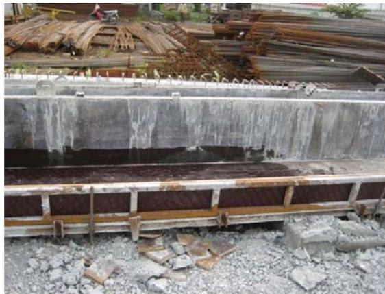
Gambar 3.3. Bekisting Balok Dari Kombinasi Baja (Bagian Dalam) dan Multiplek (Bagian Bawah dan Luar)
