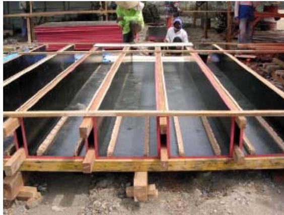
Gambar 3.12. Bekisting Kolom Dari Kombinasi Pelat Baja dan Kayu Kaso
