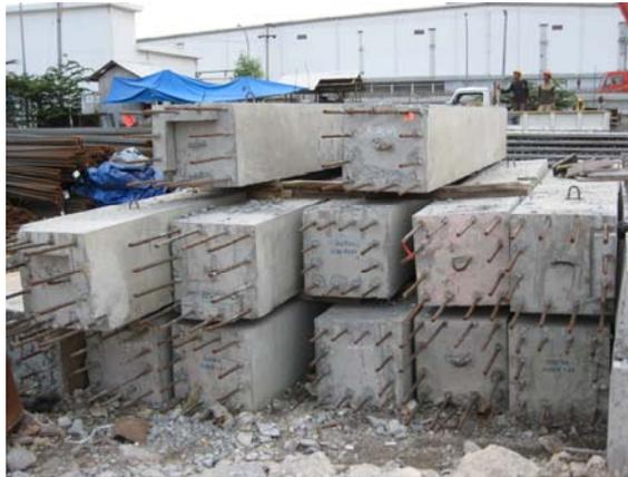
Gambar 3.17. Penumpukan Kolom Pada *Stock Yard*
