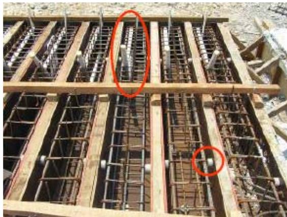
Gambar 3.14. *Setting* Tulangan Kolom di Dalam Bekisting
