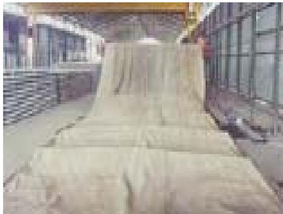
Gambar 3.25. Penutupan Beton Dengan Terpal Untuk Proses *Curing*
