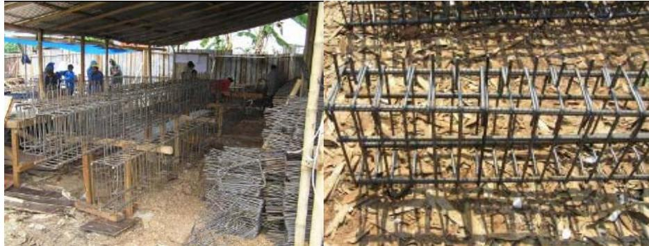
Gambar 3.4. Fabrikasi Besi Untuk Balok
