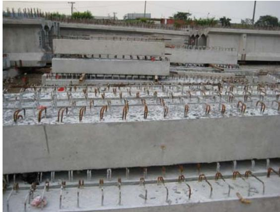
Gambar 3.10. Penumpukan Balok Pada *Stock Yard*
