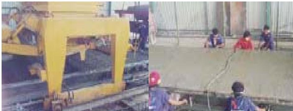
Gambar 3.23. Penuangan Beton ke Meja Cetakan (Kiri) dan Pematatan Dengan *Vibrator Eksternal* (Kanan)
