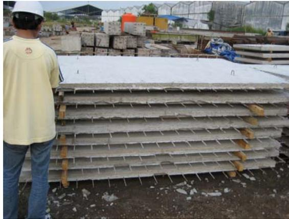
Gambar 3.27. Penumpukan *Preslab* Pada *Stock Yard*
