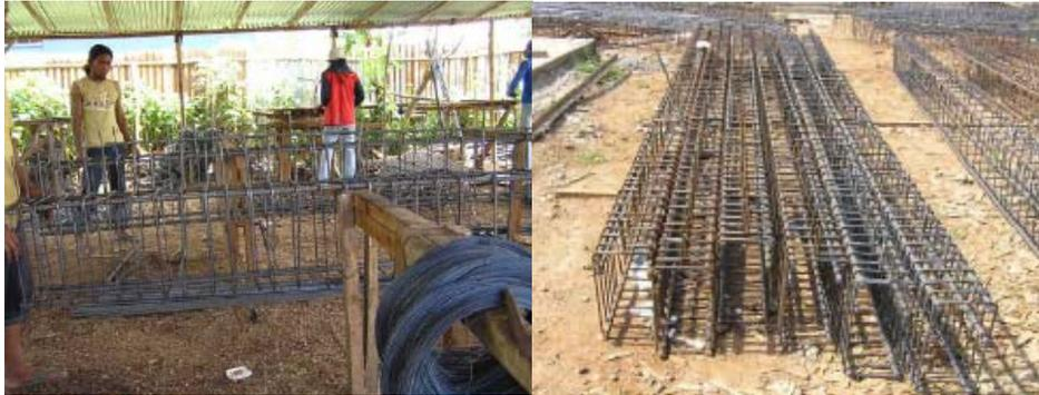
Gambar 3.13. Fabrikasi Besi Untuk Kolom
