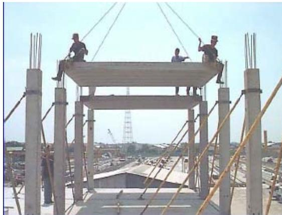
Gambar 2.2. Pemasangan Pelat Langsung Menumpu Pada Kolom
