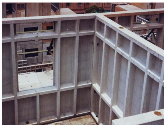
Gambar 2.1. Panel Dinding Struktur Pracetak Untuk Sistem *Waffle Crete*
