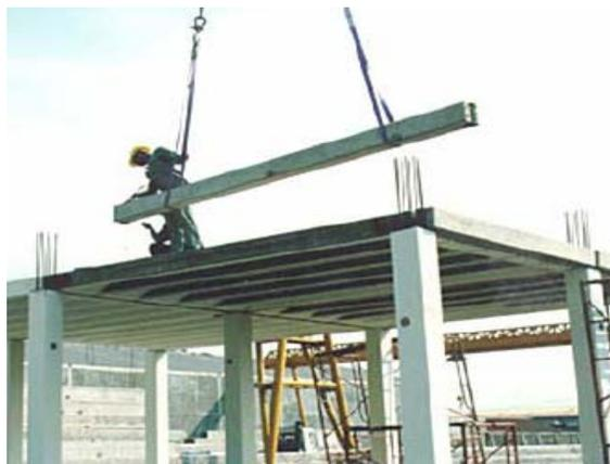
Gambar 2.3. *Side Beam* Dipasang Setelah Pelat Terpasang
