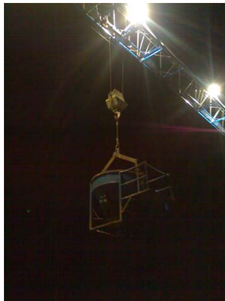
Gambar 4.5. Gerakan Swing TC pada Pengecoran Shearwall
