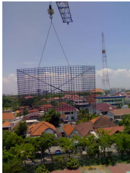
Gambar 4.1. Pengangkatan Tulangan Shearwall lantai 6
