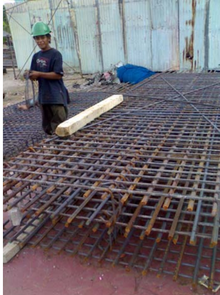
Gambar 4.11. Fabrikasi Tulangan Shearwall
