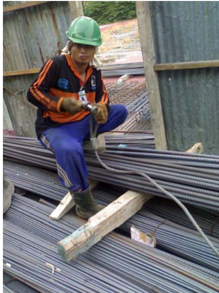
Gambar 4.10. Mengikat Tulangan Balok
