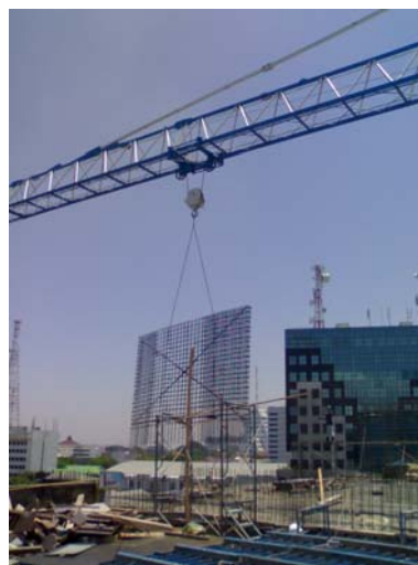
Gambar 4.13. Kondisi Lapangan pada Pekerjaan Pengangkatan Material
