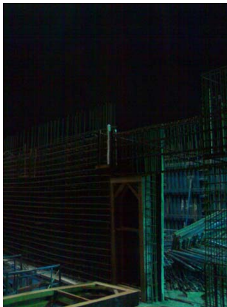
Gambar 4.4. Shearwall Sebelum Pengecoran
