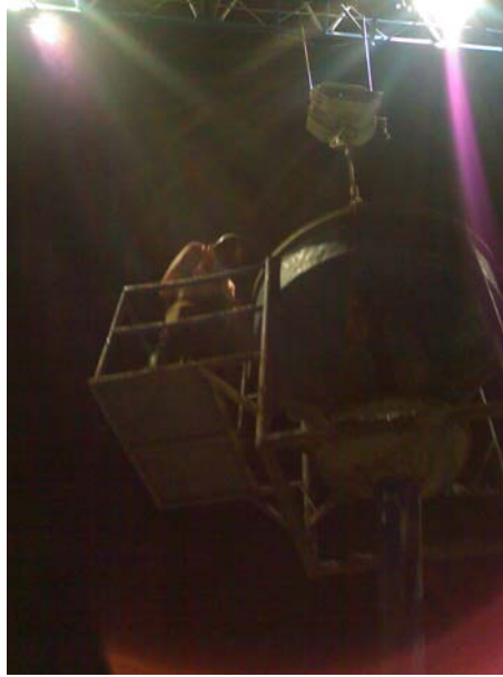
Gambar 4.6. Pengecoran Shearwall pada Malam Hari
