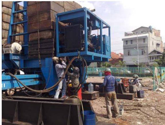
Gambar 4.35. Alat Pancang Rusak dan Sedang Diperbaiki
