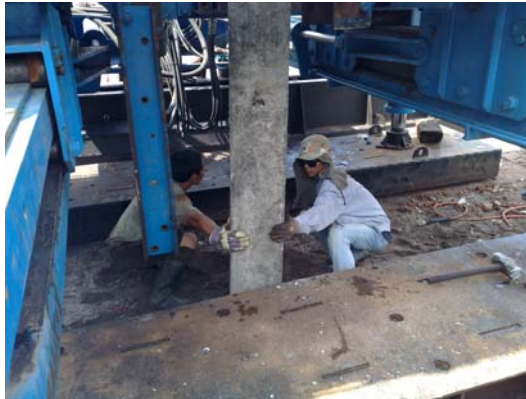
Gambar 4.39. Pekerja Berusaha Menjaga Tiang Pancang pada Posisi yang Benar
