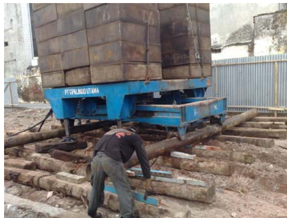
Gambar 4.9. Proses Perpindahan Alat 2 dan 3
