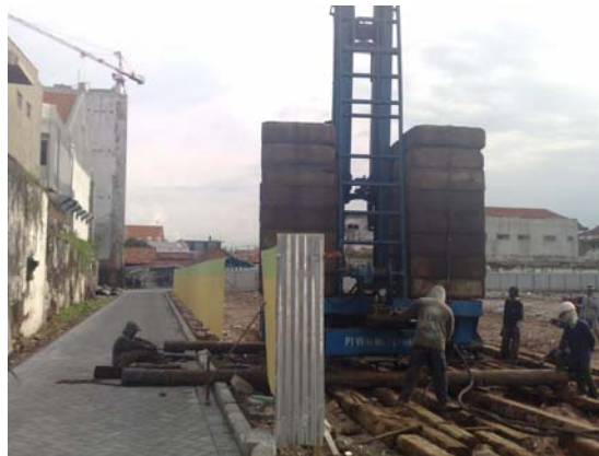
Gambar 4.50. Proses Pencarian Titik Pancang
