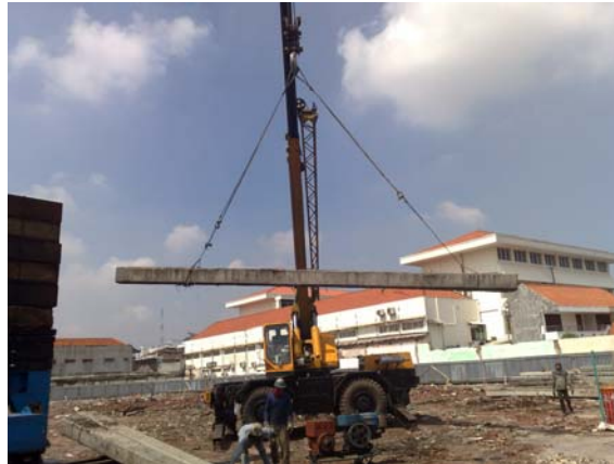
Gambar 4.10. Proses Pengangkatan Tiang Pancang oleh Mobile Crane
