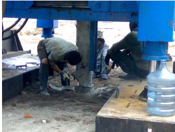
Gambar 4.16. Proses Pemotongan Tiang Pancang
