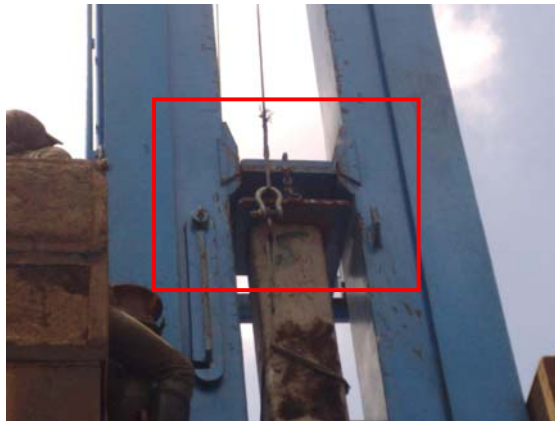
Gambar 4.12. Bentuk Clap (Plat Baja) pada Alat Jacked in Pile
