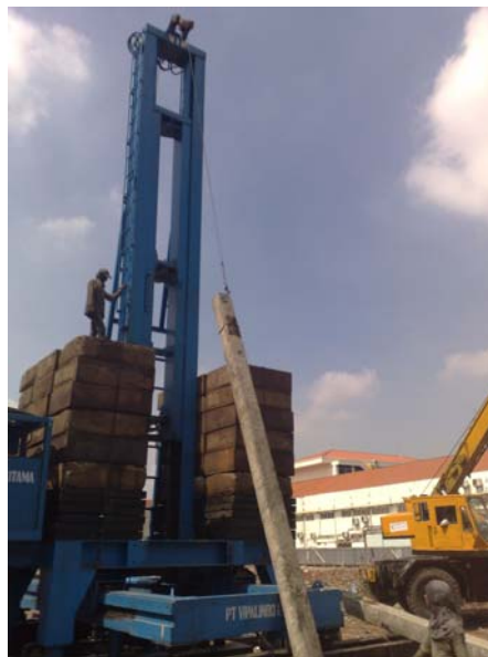
Gambar 4.11. Proses Pengangkatan Tiang Pancang oleh Alat Pancang
