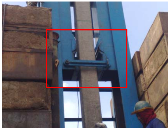
Gambar 4.13. Clap (Plat Baja) pada Kondisi Terbuka
