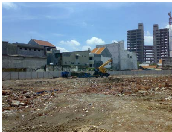
Gambar 4.3. Posisi Bangunan Tetangga Terhadap Lahan Proyek
