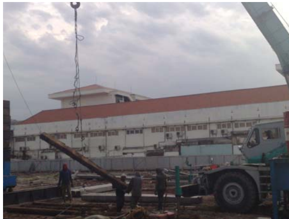
Gambar 4.42. Pemindahan Kayu Alas oleh Mobile Crane
