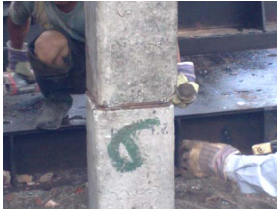
Gambar 4.14. Posisi Sambungan Tiang Pancang
