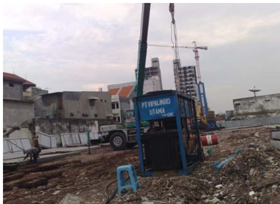
Gambar 4.34. Pemindahan Generator Alat Pancang
