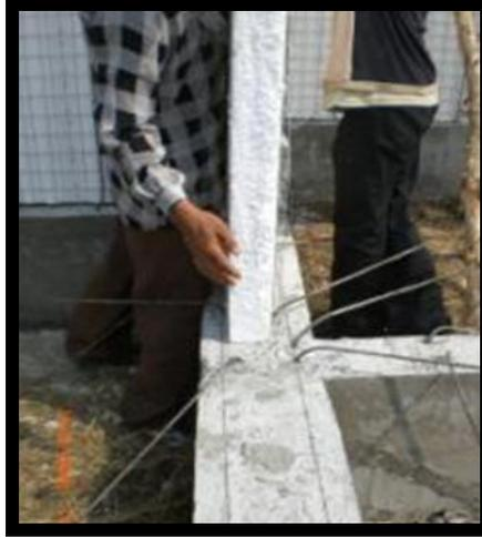
Gambar 4.4. Panel Dinding didirikan di Atas Stek Besi yang telah dibengkokkan
