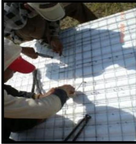
Gambar 4.2. Panel Dinding yang disambung di Lapangan
