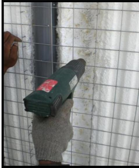
Gambar 4.17. Pembuatan Coakan pada Panel Dinding
