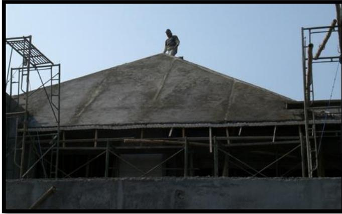
Gambar 4.14. Plaster Atap Bagian Atas yang sudah Mengeras
