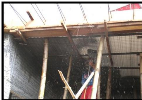
Gambar 4.19. Aplikasi *Shotcrete* pada Bagian Bawah Panel Lantai
