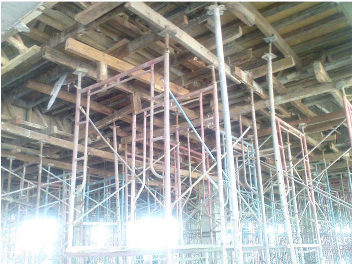
Gambar 2.10. Sambungan Frame-Formwork
