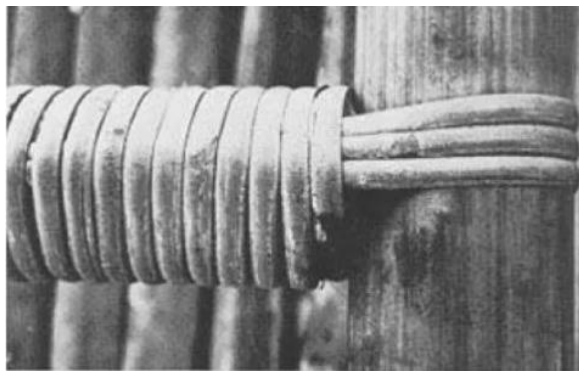
Gambar 2.20 Pola Ikatan dengan Anyaman Rotan
